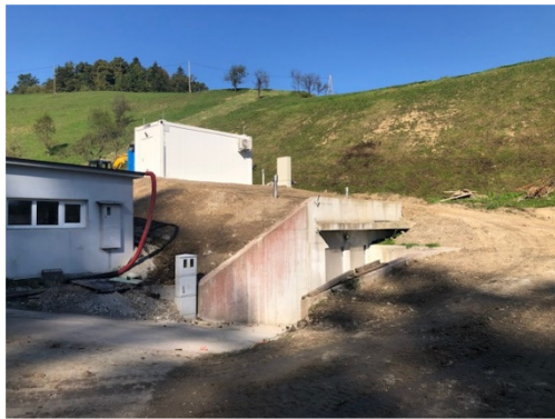
Slika: Zaključevanje del na UF Jepihovec
